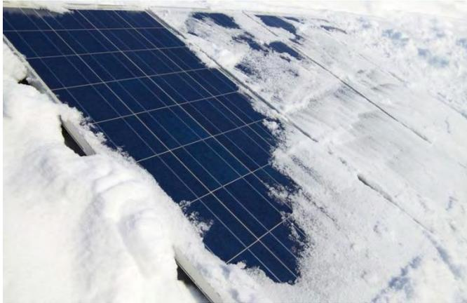
Abbildung 6-9: Solarmodule mit Schneelast (Quelle:www.solaranlage.eu)
